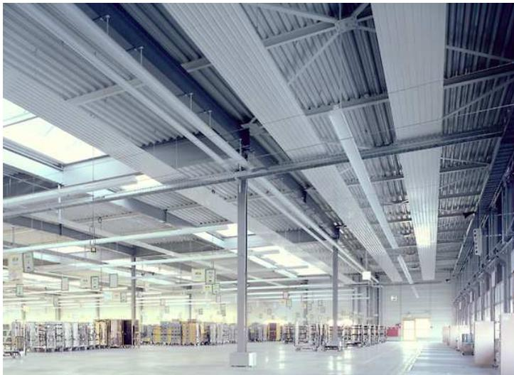
Deckenstrahlplatten können als anschlussfertige Einheiten geliefert oder aus mehreren Elementen zu Bändern von bis zu 120 m Länge zusammengefügt werden. Zur Abdeckung des erforderlichen Wärmebedarfs müssen ca. 15 – 20 % der Deckenfläche mit Strahlplatten belegt werden. Die Montagehöhe liegt in der Regel zwischen ca. 3 und 40 m. Da die Beheizung indirekt über einen externen Wärmeerzeuger erfolgt, ist auch der Einsatz in explosionsgefährdeten Räumen möglich.
